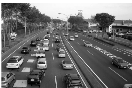
郊外の開発により 渋滞がひどくなる R51 米沢陸橋付近。
